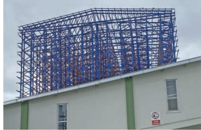
Cephe Giydirme Öncesi / Before Clad Rack
