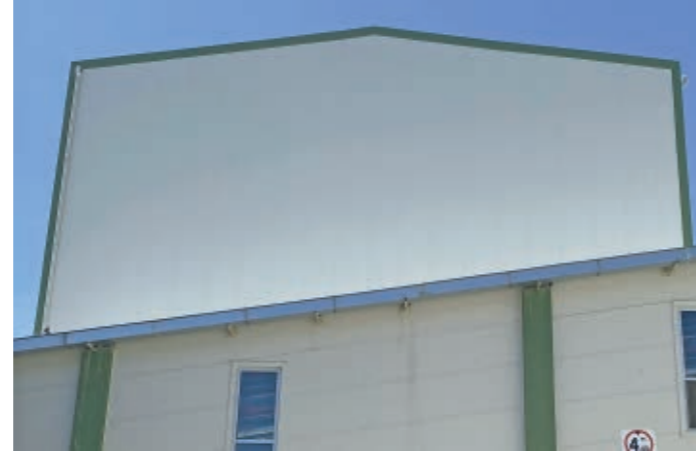
Cephe Giydirme Sonrası / After Clad Rack
